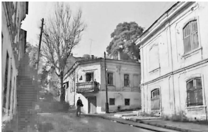
Переулок Почтовый (до реконструкции)
